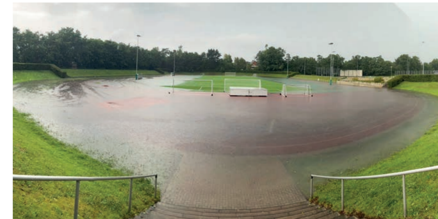
Sportplatz und Regenrückhalt: Das Hein-Klink-Stadion im Bau (oben, Foto: Krafft Angerer / HW) und nach dem Starkregen am 7. August (Foto: Bezirksamt Hamburg-Mitte)
