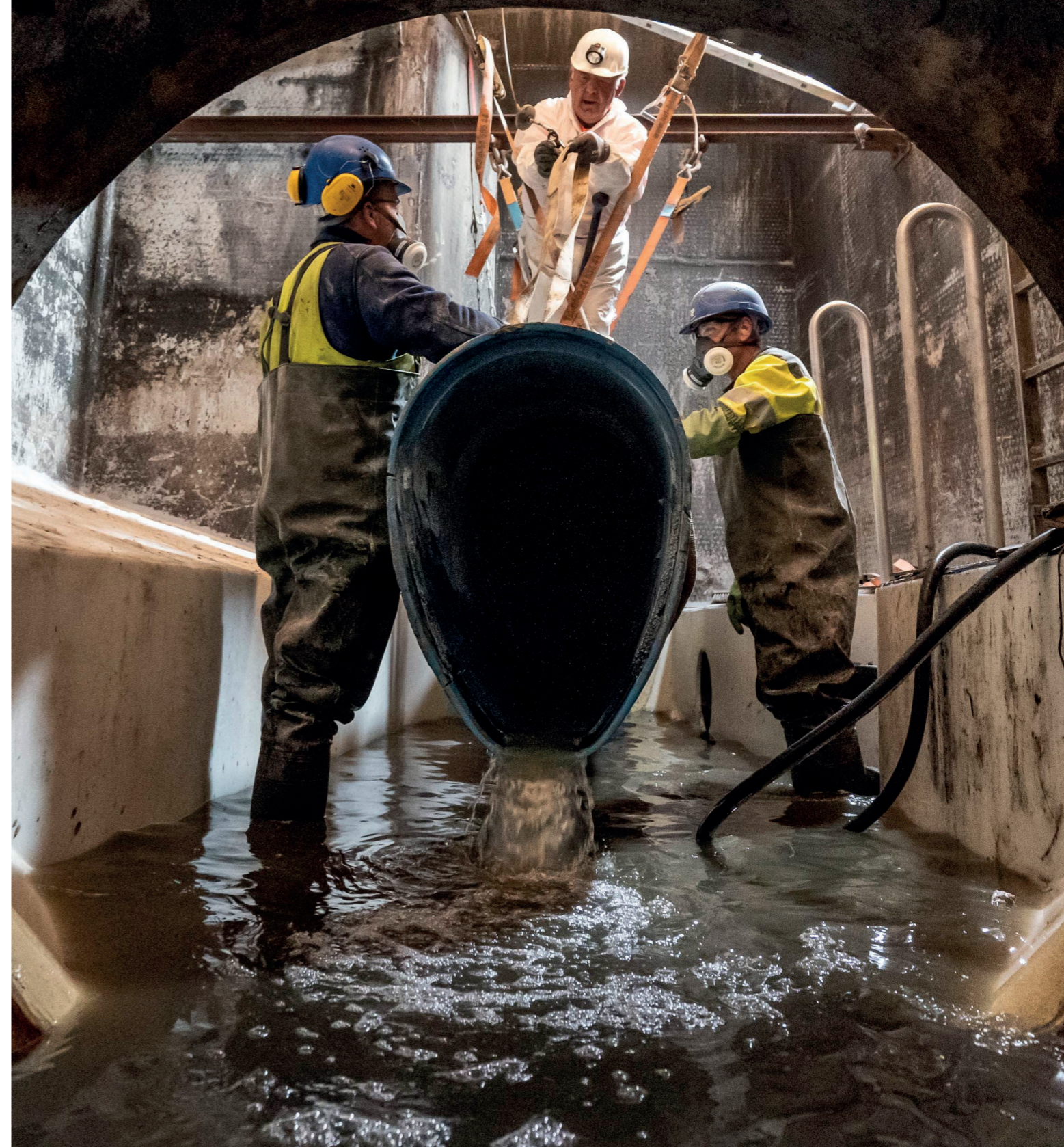
Entfernung der inneren Verrohrung im Transportsiel in Altona. Foto: Krafft Angerer / HW
