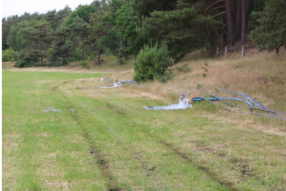
Foto 9: Versickerung von Rohwasser im Tal des Weseler Baches, im Bild 3 von 8 Auslässen (Juni 2022)
