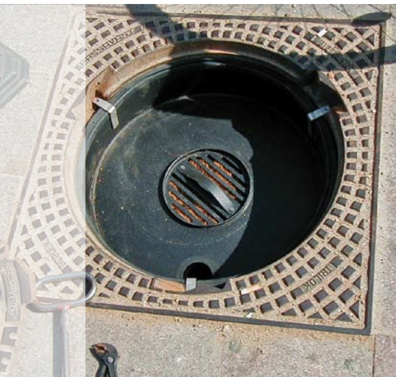
Abbildung 33: Kanalschachtfilter
