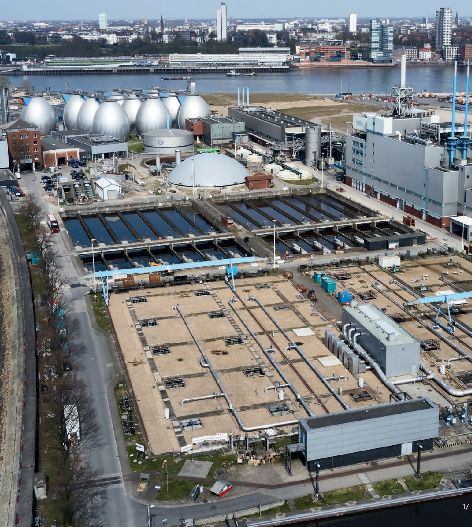
Klärwerk Hamburg auf dem Köhlbrandhöft. Foto: Kristina Steiner / HW
