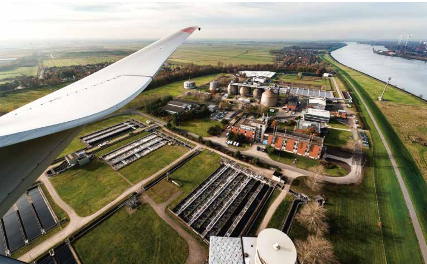
Das Klärwerk in Bremen-Seehausen liegt direkt an der Weser, über die früher der Klärschlamm per Schiff nach Hamburg transportiert wurde.
