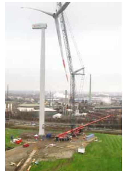
AUF DEM ENERGIEBERG WIRD DER FERTIGE ROTOR AN DER GONDEL MONTIERT. HAMBURG ENERGIE PLANT 2015 DEN BAU VON WEITEREN SECHS ANLAGEN DIESER GRÖSSE IM HAMBURGER HAFEN.
