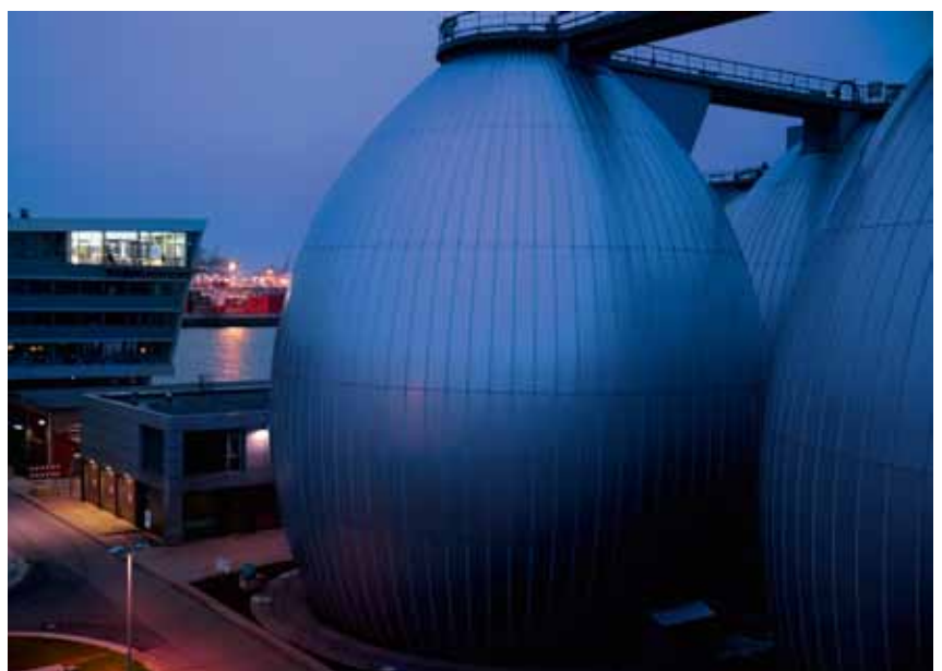
AUS SCHLAMM WIRD GAS: IN DEN FAULTÜRMEIN WIRD KLÄRSCHLAMM IN STÄDTISCHES BIOMETHAN UMGEWANDELT.
