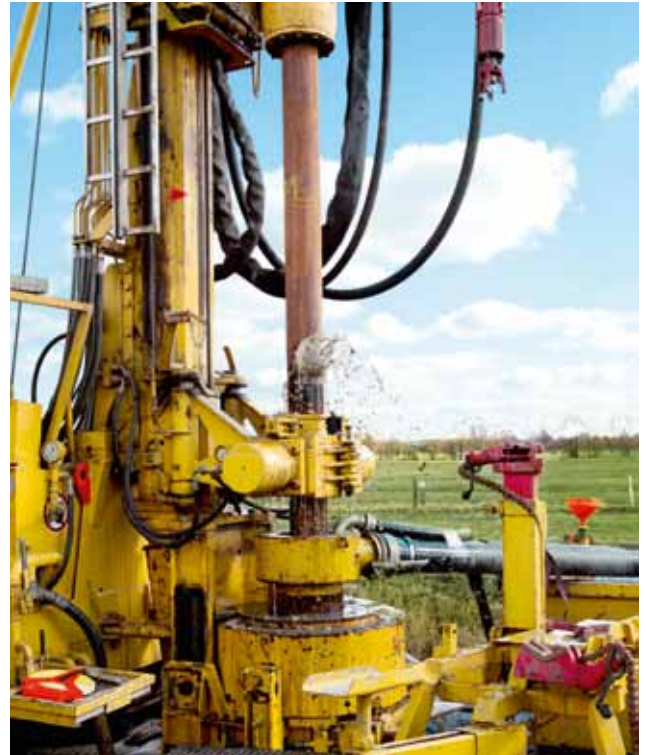
DIE BOHRUNG IN DER HASELDORFER MARSCH IST EIN AKTUELLES PROJEKT VON HAMBURG WASSER UND DEM TOCHTERUNTERNEHMEN CONSULAQUA.
